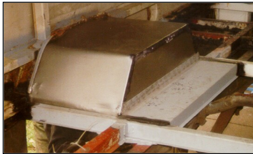
Abb. 16: Radkasten links (Neufertigung)
