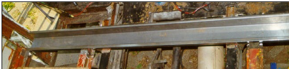
Abb. 7: Kastenträger Unterteil eingepaßt, unverschweißt
