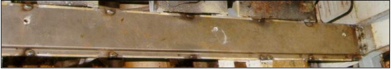
Abb. 13: Deckel auf Kastenträger geschweißt
