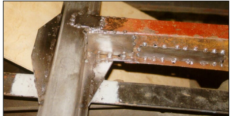
Abb. 5: Knotenblech verschweißt
